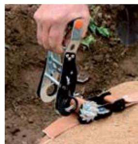
Une profondeur d'enfoncement plus importante augmente la tenue des ancrés
