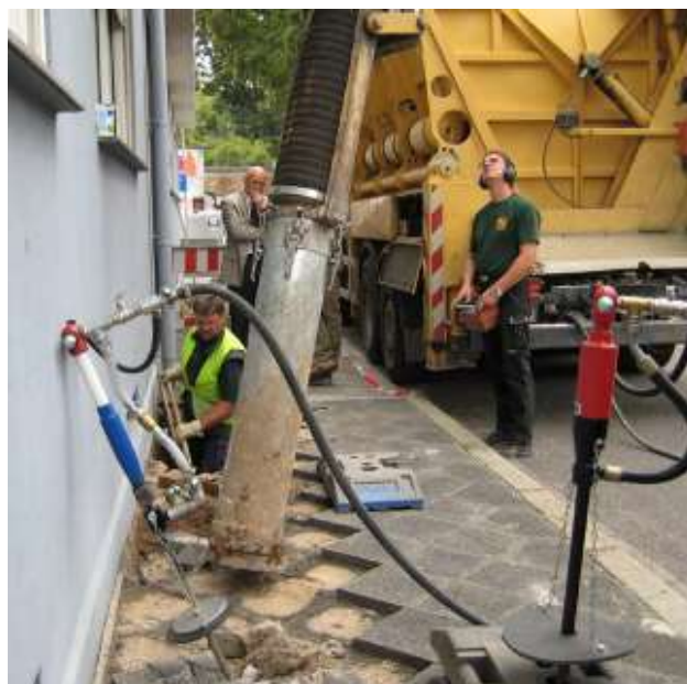
Travail combiné avec l'aspiratrice excavatrice
