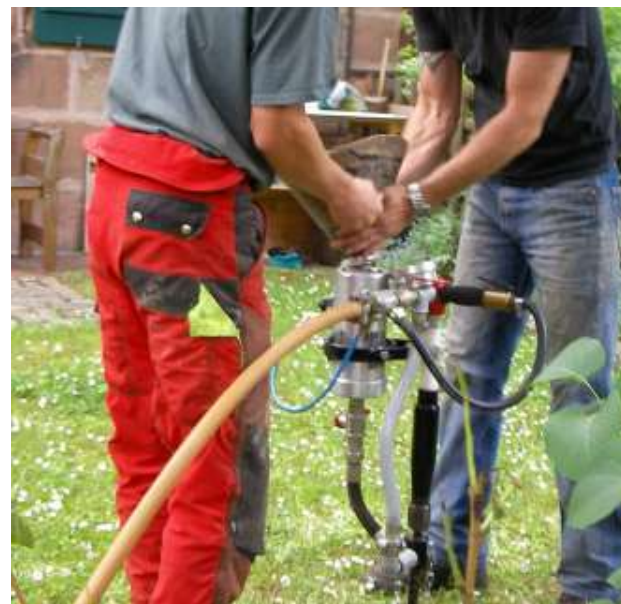
Remplissage du réservoir avec des matières solides
