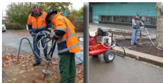
Injection dans la fosse de plantation en zone urbaine
