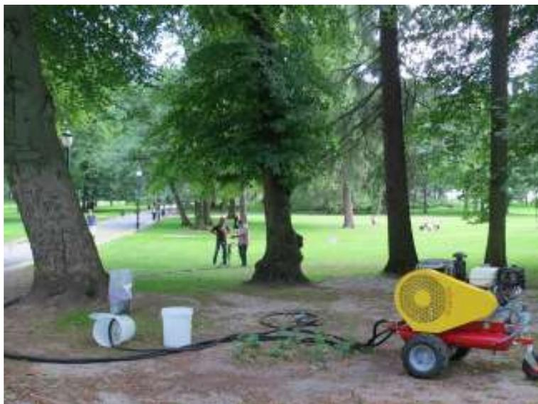
Un compresseur thermique autonome fournit l'air nécessaire à la lance d'injection afin d'injecter la solution humique et les hydro rétenteurs.
